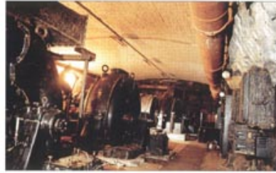
Maschinenraum am Drei-Brüder-Schacht (Gegenwärtiger Zustand)
